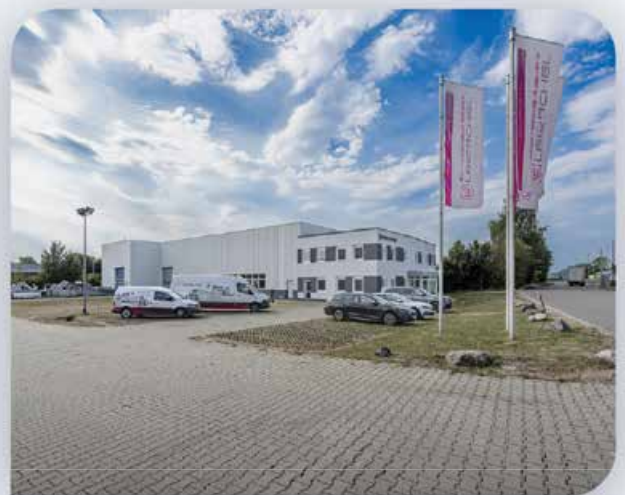
Der GPS Reisacher Firmenstandort in Bad Grönenbach
